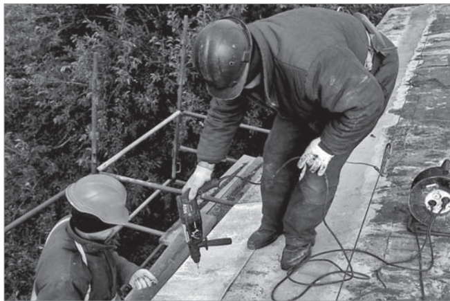
Покрівельні роботи в насосному відділенні цеху М-6
