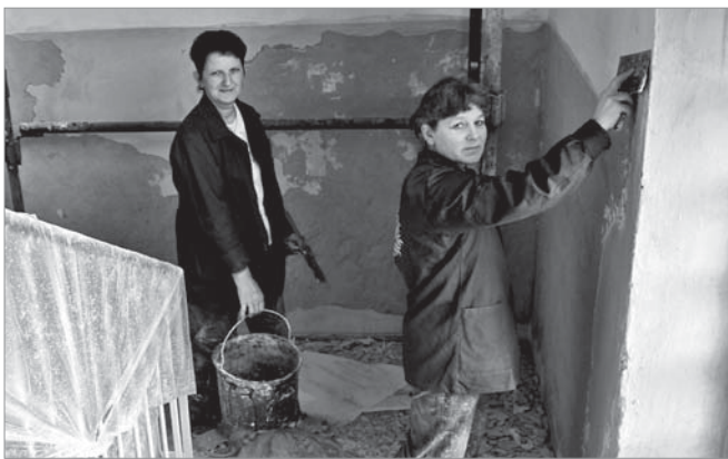
Ремонти у школах виконували працівники бригад оздоблювальних та загальнобудівельних робіт ремонтно-будівельного цеху ПАТ «АЗОТ» OSTCHEM.
