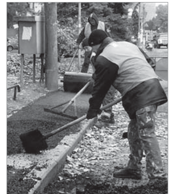
Ремонт доріг у Черкасах
