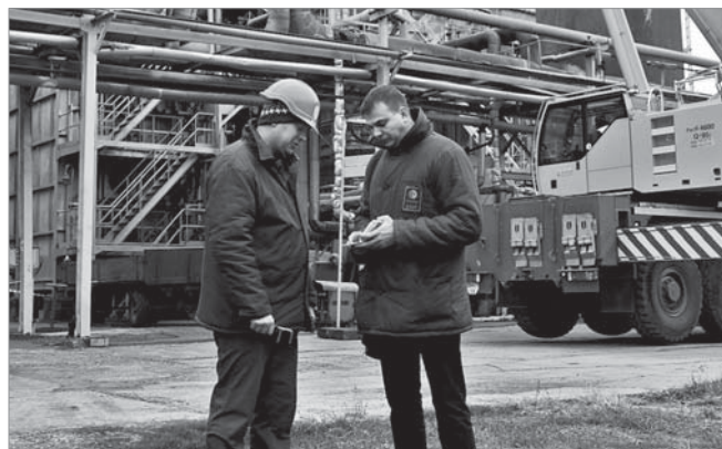
Старший апаратник Ю.Кравець та інженер-технолог В.Половий біля котла поз. 101-ВУ, де триває ремонт даху
