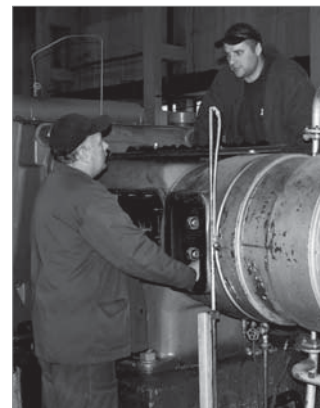
Ремонтні роботи у відділенні компресії
