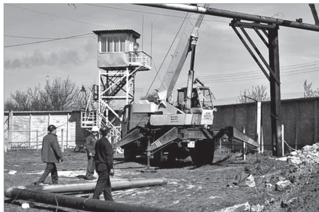
Ремонтники демонтували частину колектора
