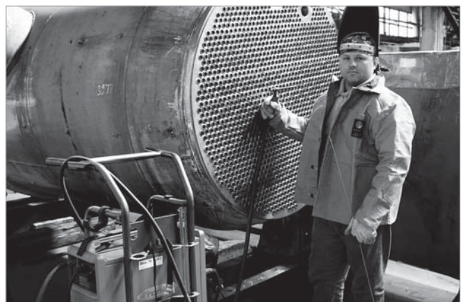
Електрозварник В.Шкарбута задіяний в ремонті холодильника-конденсатора для цеху М-5
