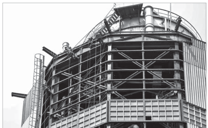
Здійснюються роботи з оновлення «грибка» башти
