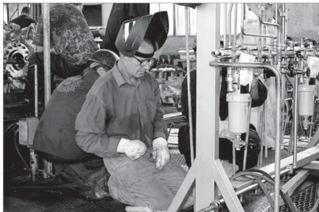
Зварювальник УКР Федір Слободський працює над монтажем газодинамічних ущільнювачів компресора природного газу
