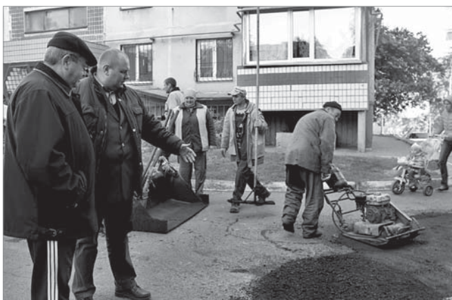
Максим Скорик особисто контролював ремонт проїздів
