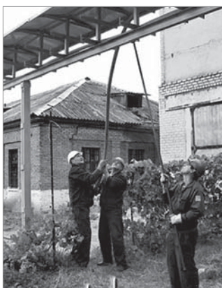
Роботи по прокладці кабелю
