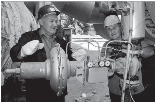
Слюсарі-ремонтники УКР М.М.Бойко та І.І.Вінник під час капремонту і діагностування обладнання в цеху А-3
