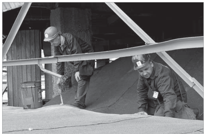
Ремонт покрівлі – один із першочергових
