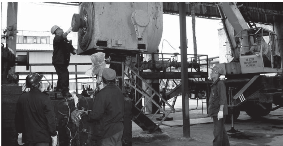
Працівники ЦЦР та М-9 встановлюють відремонтований електродвигун
